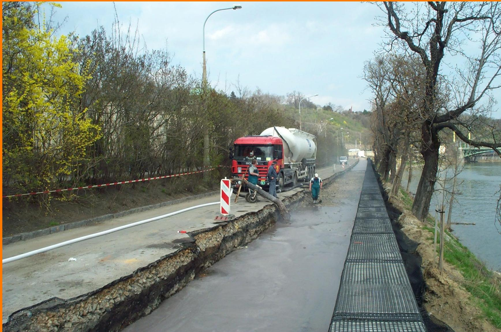
Stabilizát je vhodný pro vyplnění volných prostor, které zůstanou ve stavebních jamách mezi hotovým objektem a stěnou stavební jámy, případně záporovým pažením, kterým je jáma zajištěna.
