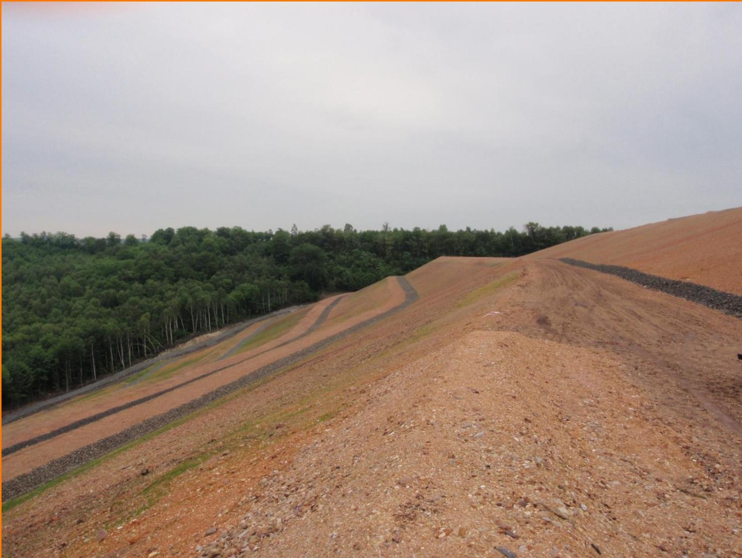
Aplikací stabilizátu po vrstvách s postupným budováním záchytných hrází lze upravovat budoucí terén do téměř libovolného tvaru.
