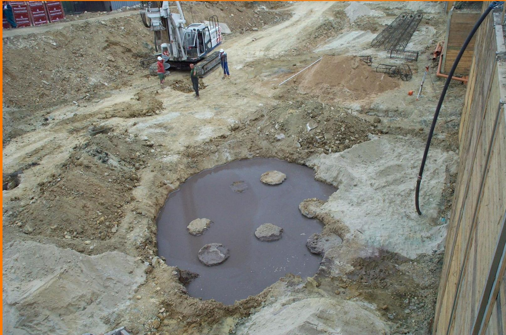
Ideální je použití stabilizátu pro vyplnění obtížně přístupných prostor v okolí hloubených částí tunelů, jak tomu bylo např. na stavbě železničních tunelů „Nové spojení“ v Praze.
