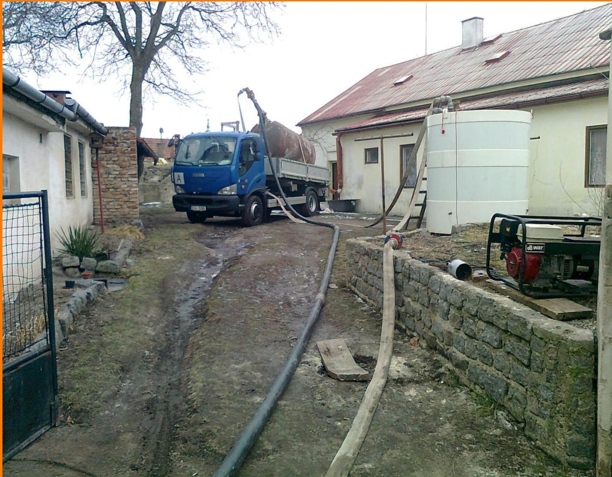
U rozsáhlých vyplňovaných prostor je optimální aplikovat stabilizát ve vrstvách o tloušťce 0,3 až 0,5 metru. Díky obsahu volného CaO v popílku a jeho následné reakci s vodou namíchaná směs tuhne obdobně jako malta. Za standardních podmínek je litá vrstva stabilizátu po jednom dni pochozí, po vyzrání dosahuje materiál pevnosti v prostém tlaku přes 1 MPa.
