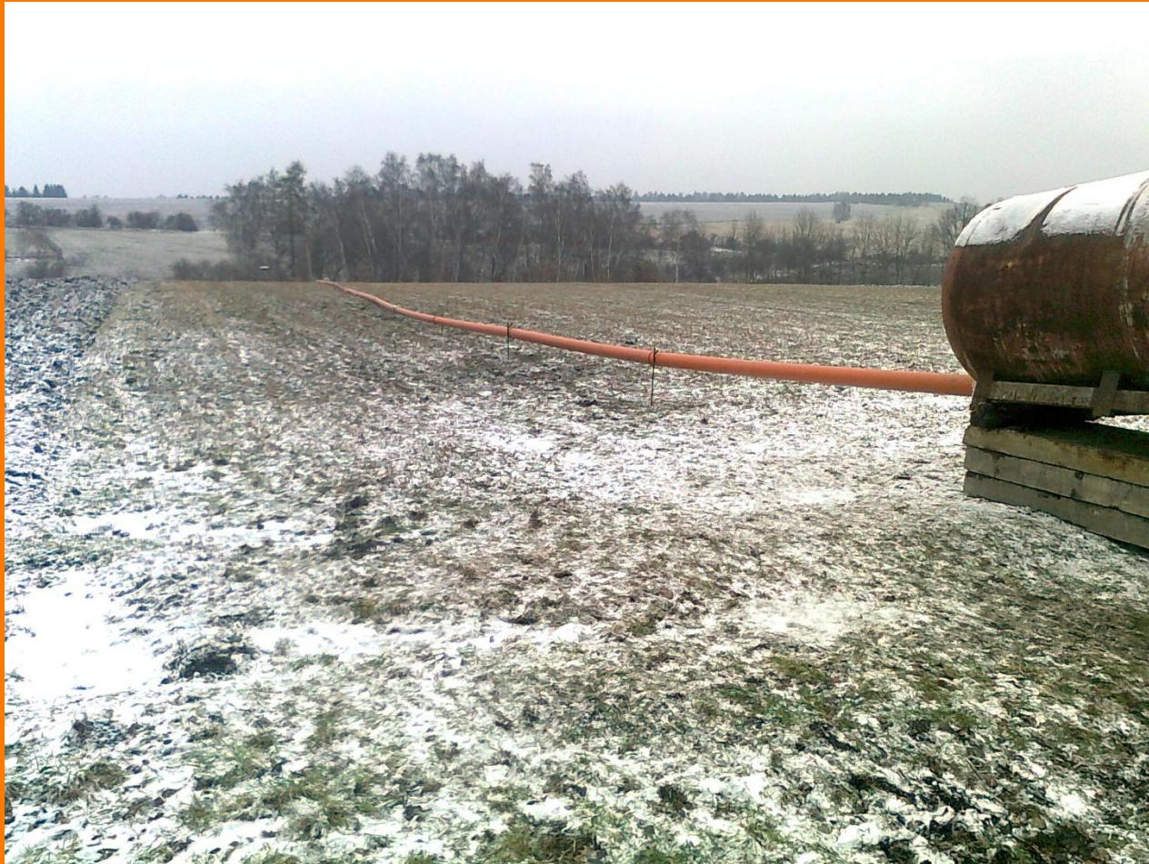
Podmínkou pro úspěšné míchání směsi je kapacitní zdroj vody o vydatnosti min. 500 l/min a tlaku min. 2 atm. V případě, že kapacitní zdroj chybí, je možno instalovat vyrovnávací nádrž, ze které je záměsová voda čerpána ponorným čerpadlem.
