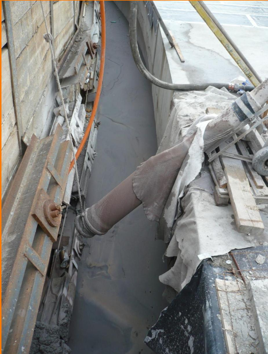
Stabilizát je dále možno použít např. pro vyplnění volných prostor po položení kanalizačního řadu v profilu ražené štoly,
