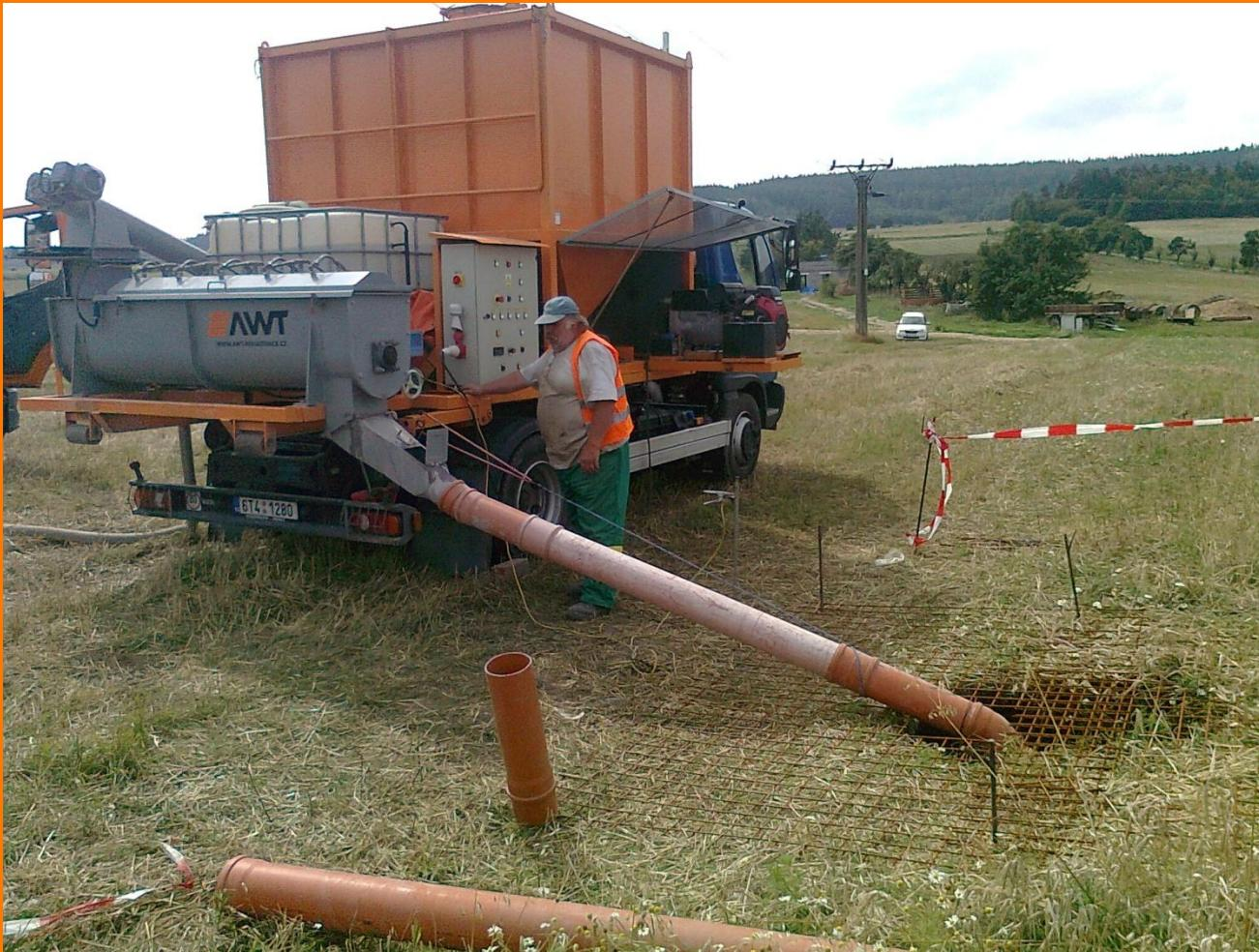
Při likvidaci (zásypu) nefunkční kanalizace bez nutnosti provádět výkopové práce:
