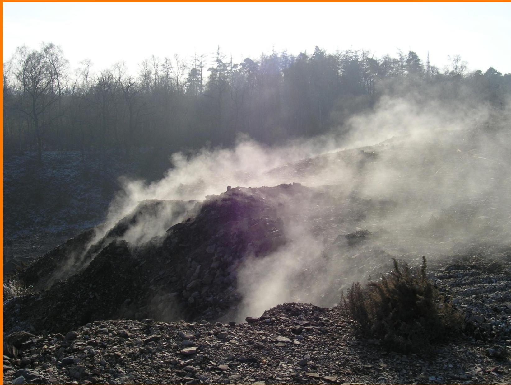
Dle zpracované projektové dokumentace bylo celé těleso odvalu postupně pokryto izolační vrstvou stabilizátu o mocnosti 0,5–1m, která odval utěsnila a zamezila tak jeho dalšímu hoření.
