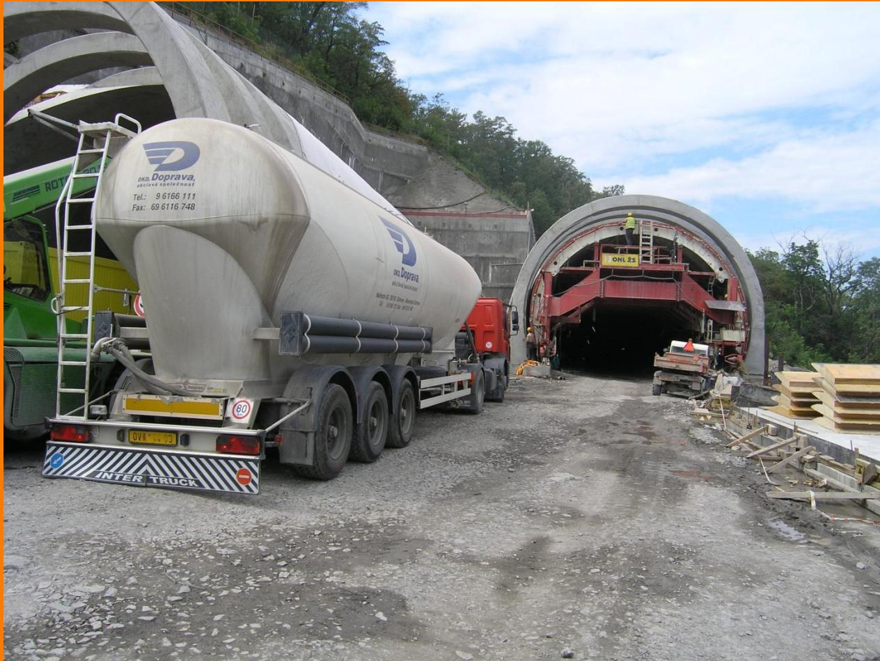
Přímo na místě je v jednoduchém mobilním zařízení smíchán s vodou v poměru přibližně 1tuna popílku na 1,5 až 2 m<sup>3</sup> vody
